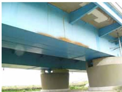
パトロール時に確認された桁の発錆
