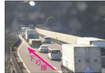
広幅IC～潮トンネル間： 3%の上り坂が続き、渋滞が発生
