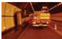
トンネル清掃
