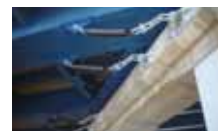
耐震補強(落橋防止装置)
