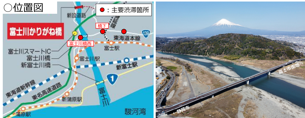
開通後（令和6年3月）
