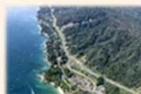
三陸沿岸道路（岩手県山田町）
