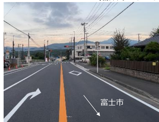
右折レーン設置後
