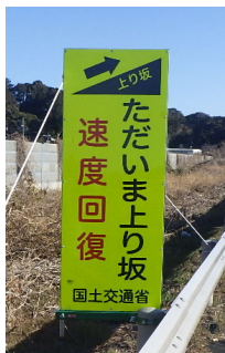
SL看板設置状況
