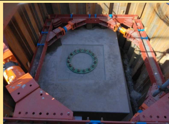
横砂東道路建設工事 工事進捗状況
