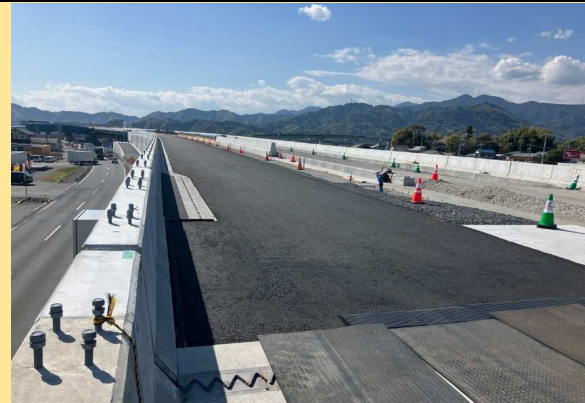
横砂尾羽地区南舗装工事 工事進捗状況
