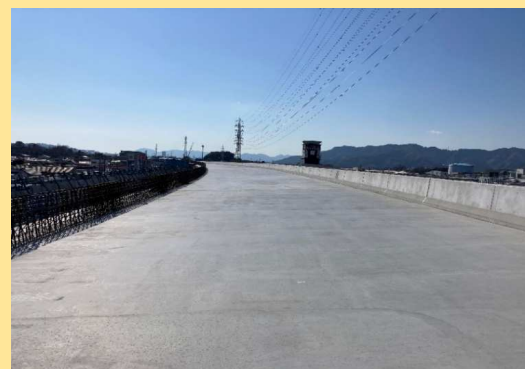
1号清水立体整備工事 工事進捗状況
