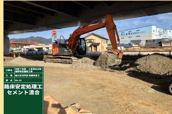
庵原地区舗装工事 工事進捗状況
