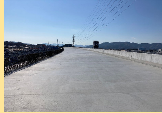
庵原高架橋床版工事 工事進捗状況
