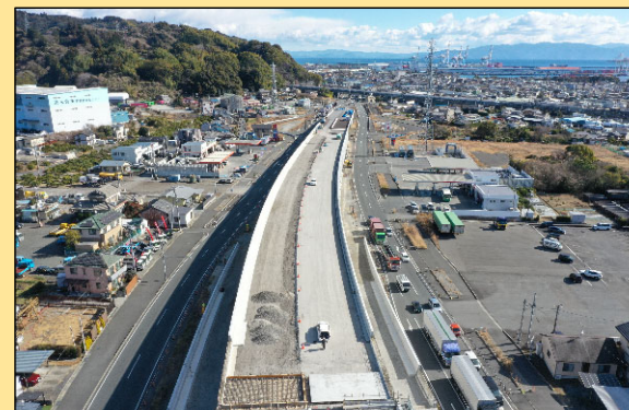
横砂尾羽地区北舗装工事 工事進捗状況
