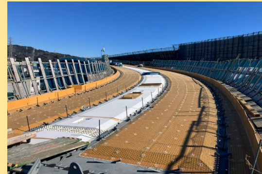
西久保地区床版工事 工事進捗状況
