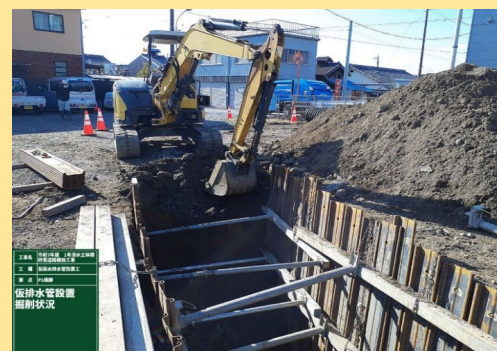
横砂東道路建設工事 工事進捗状況
