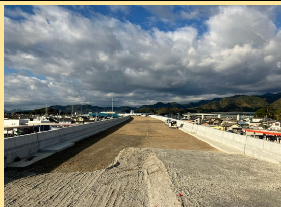
横砂尾羽地区南舗装工事 工事進捗状況
