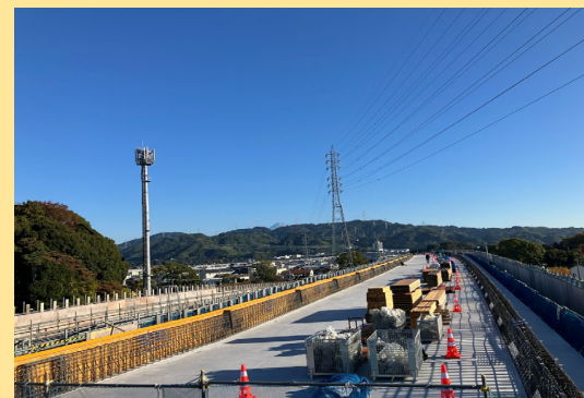
高架橋付属物整備工事 工事進捗状況
