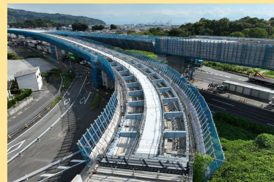
西久保地区床版工事 工事進捗状況
