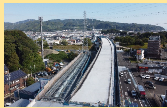
清水IC第3高架橋床版工事 工事完成
