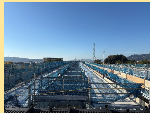
清水IC第2床版工事 工事進捗状況
