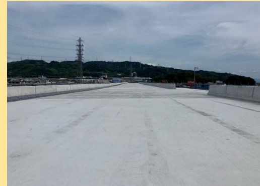
清水IC第1高架橋床版工事 工事進捗状況
