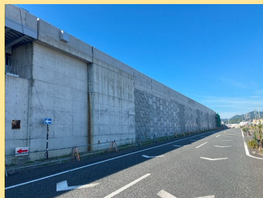
横砂尾羽地区道路建設工事 工事進捗状況
