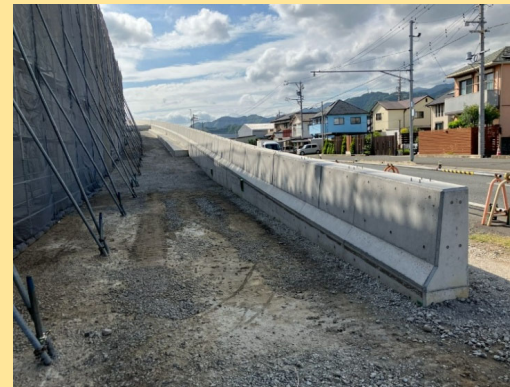
尾羽地区道路建設工事 工事進捗状況
