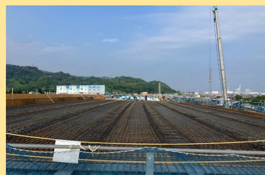
尾羽第1高架橋床版工事 工事進捗状況
