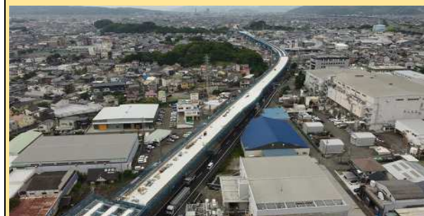
高架橋付属物整備工事 工事進捗状況
