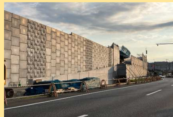
尾羽地区道路建設工事 工事進捗状況
