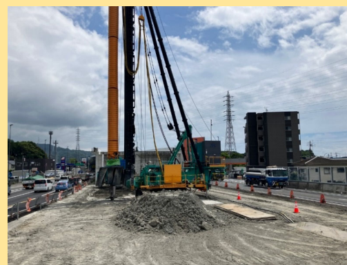
清水IC八坂東地区道路建設工事 工事進捗状況
