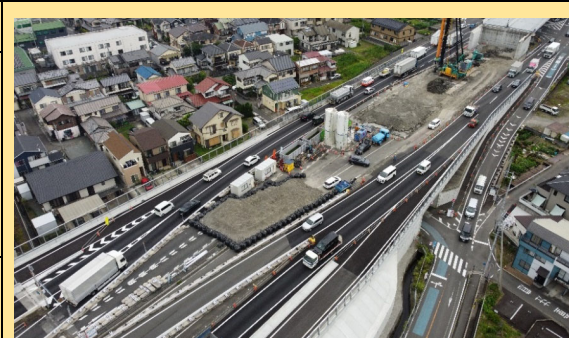
※写真は現在施工中の鈴与建設さんの改良工事
