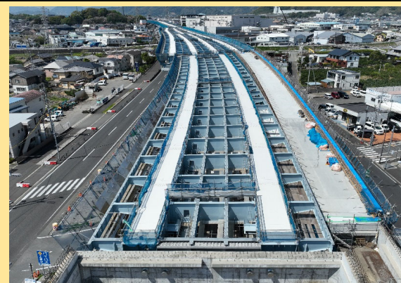
尾羽第1高架橋床版工事 工事進捗状況
