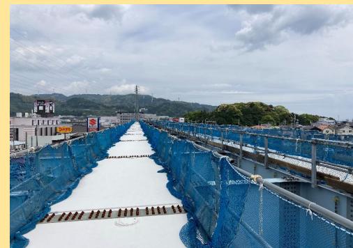
庵原高架橋床版工事 工事進捗状況
