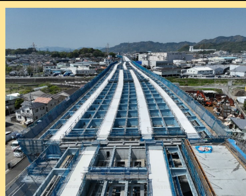
尾羽第2高架橋床版工事 工事進捗状況
