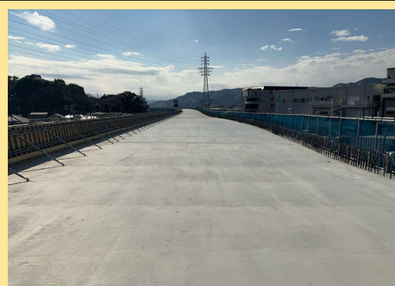
高架橋付属物整備工事 工事進捗状況
