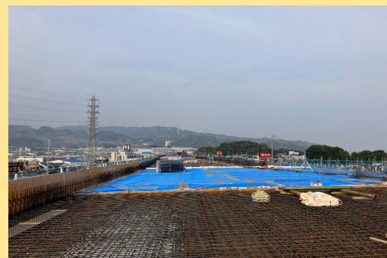
清水IC第1 高架橋床版工事 工事進捗状況
