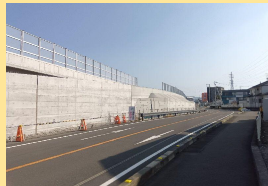
清水IC第3高架橋鋼上部工事 工事進捗状況
