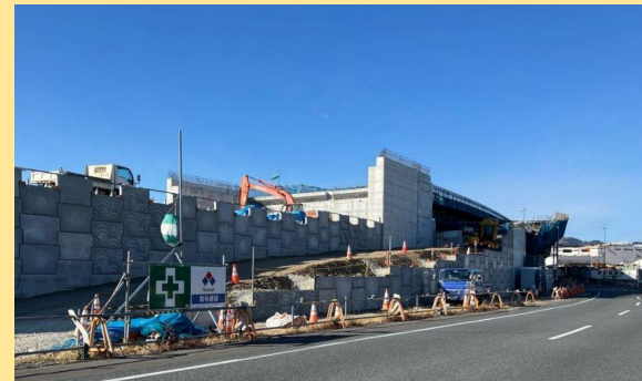
尾羽地区道路建設工事 工事進捗状況
