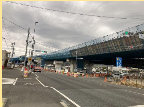
尾羽第1高架橋鋼上部工事 工事進捗状況
