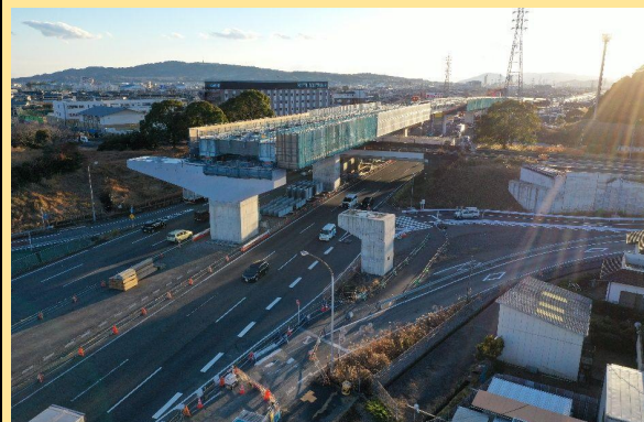
清水IC グランプ橋鋼上部工事 工事進捗状況
