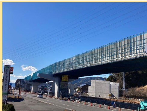
清水IC第3高架橋鋼上部工事 工事進捗状況
