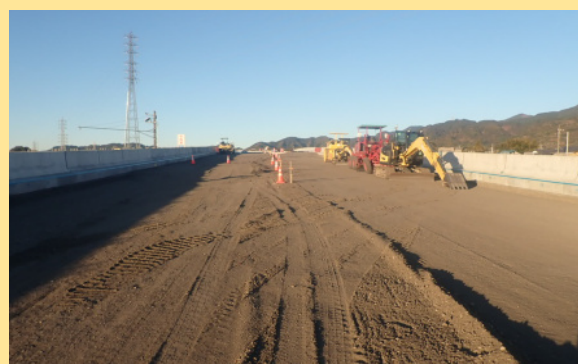
清水立体東舗装工事 工事進捗状況
