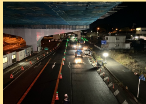
清水立体西舗装工事 工事進捗状況
