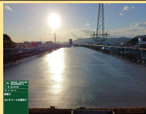
尾羽第3高架橋床版工事 工事進捗状況
