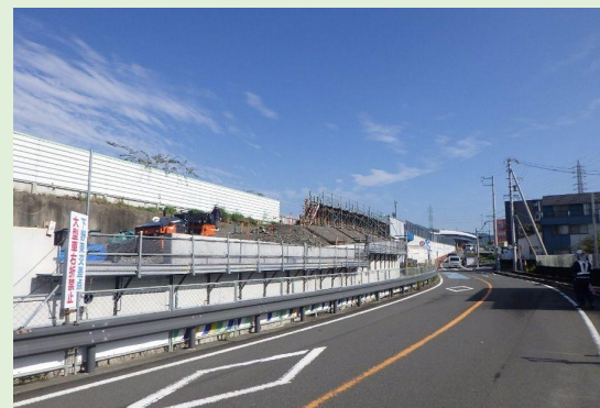
飯田地区南道路建設工事 工事進捗状況
