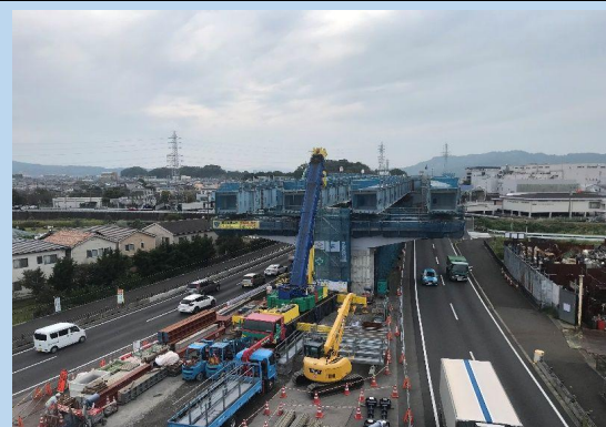
尾羽第2高架橋鋼上部工事 工事進捗状況
