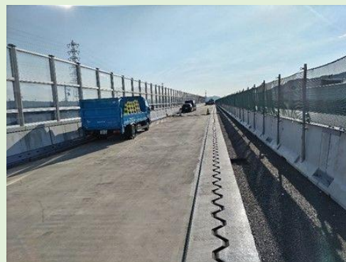
飯田地区舗装設備工事 工事進捗状況
