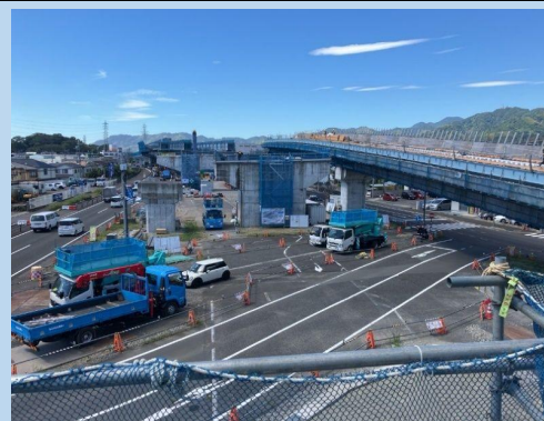
尾羽第1高架橋鋼上部工事 工事進捗状況
