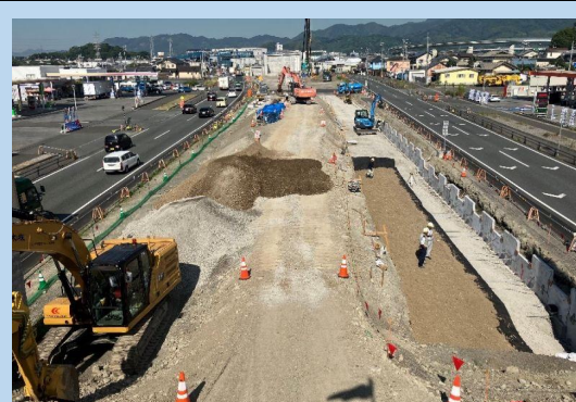
横砂尾羽地区道路建設工事 工事進捗状況
