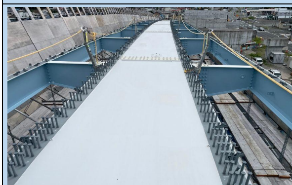
尾羽ICOFFラップ橋鋼上部工事 工事完成状況
