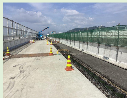
飯田地区舗装設備工事 工事進捗状況
