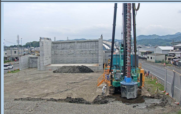
尾羽地区道路建設工事 工事進捗状況
