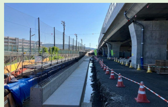
飯田地区北道路建設工事 工事進捗状況
