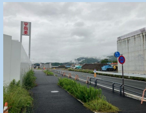
横砂尾羽地区道路建設工事 工事進捗状況
