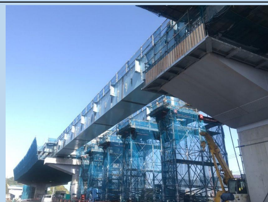
尾羽第2高架橋上部工事 工事進捗状況
