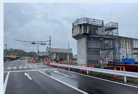
尾羽ICOFFラフ橋鋼上部工事 工事進捗状況
