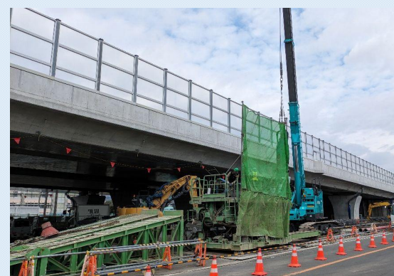
飯田地区南道路建設工事 工事進捗状況
