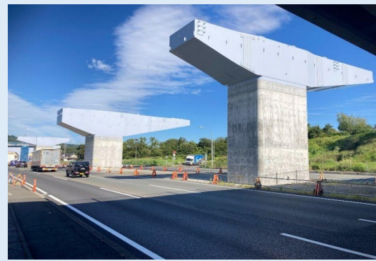
清水IC第2高架橋鋼製梁工事 工事進捗状況
