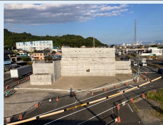
尾羽第1高架橋下部工事 工事進捗状況
