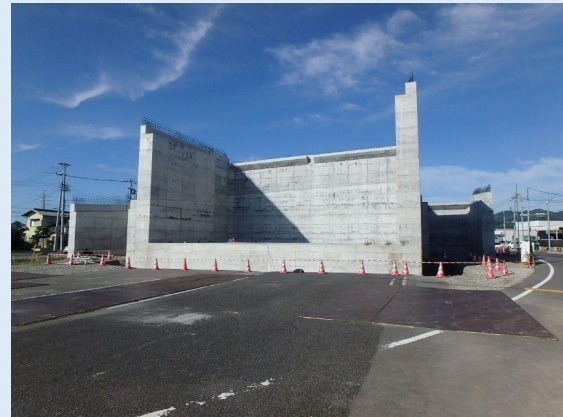
尾羽第1高架橋下部工事 工事進捗状況
