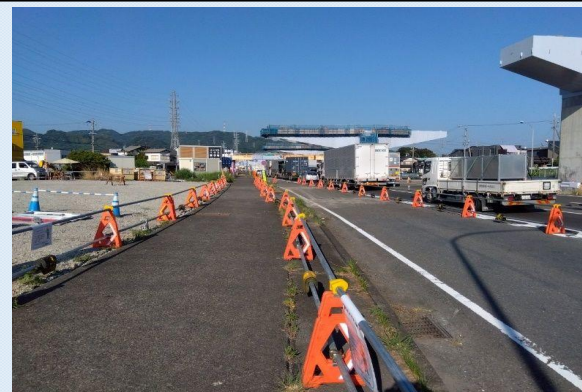
清水IC下部工事 工事進捗状況
