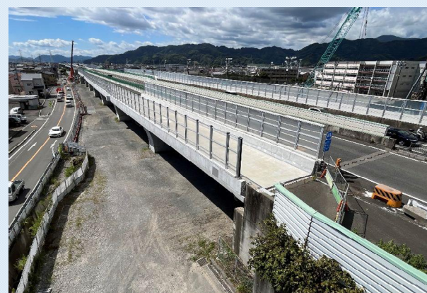
飯田ONランプ橋PC上部工事 工事進捗状況
