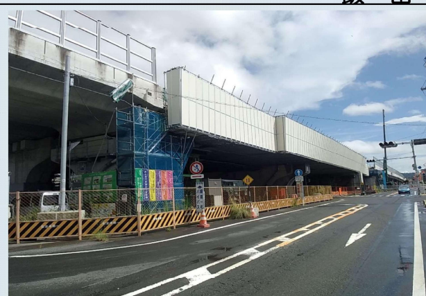
横砂跨道橋鋼上部工事 施工状況
