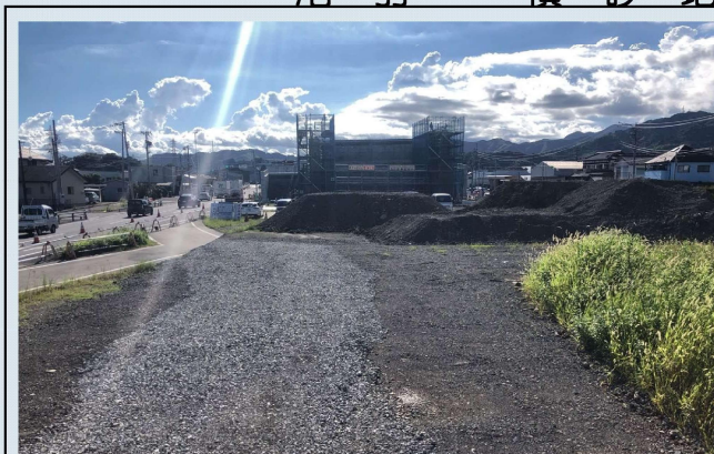
清水立体道路建設工事 着手前
