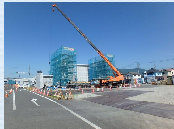
尾羽第1下部工事 施工状況
