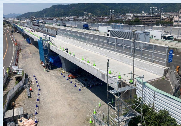
飯田ONランプPC上部工事 施工状況
