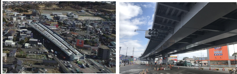
A2～P30橋脚間 上部工
