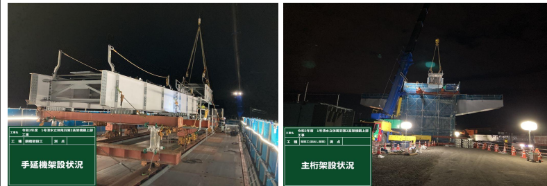
P5～P2橋脚間 上部工
