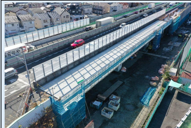
飯田OFFランプ橋 コンクリート打設完
