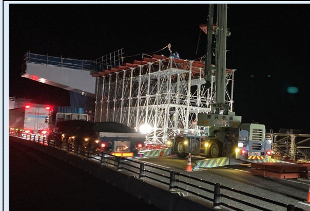
P3橋脚～P4橋脚 送り出し架設用構台組立
