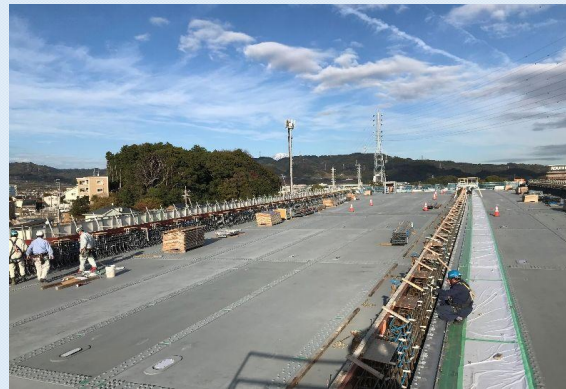
八坂高架橋 壁高欄施工状況
