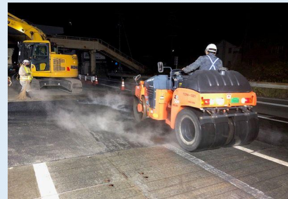
P23橋脚 仮舗装状況
