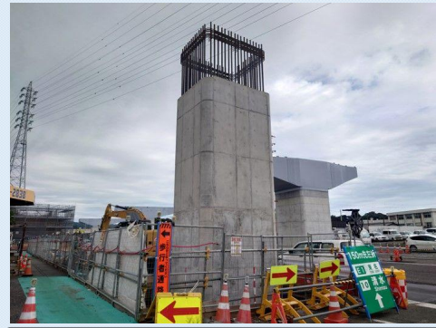
清水IC フランプP2橋脚 施工状況
