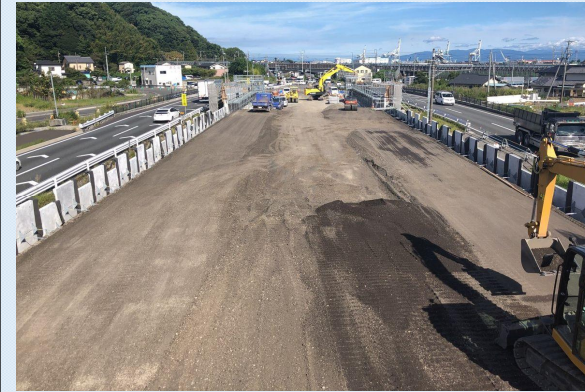
横砂地区(東京側を望む) 補強土壁施工
