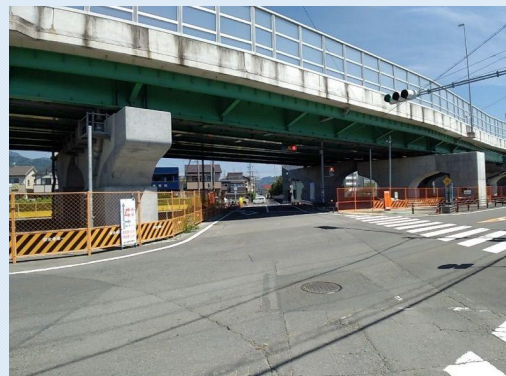
飯田高架橋 鋼橋上部拡幅工施工前
