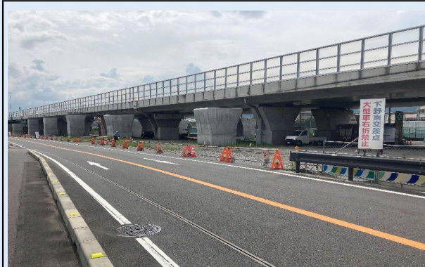
飯田ONランプ橋 上部工施工前
