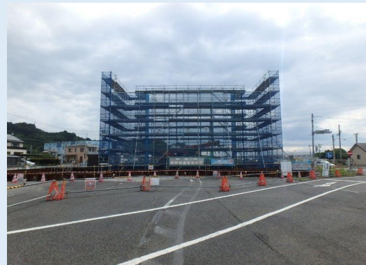
尾羽地区 本線A1橋台 施工状況
