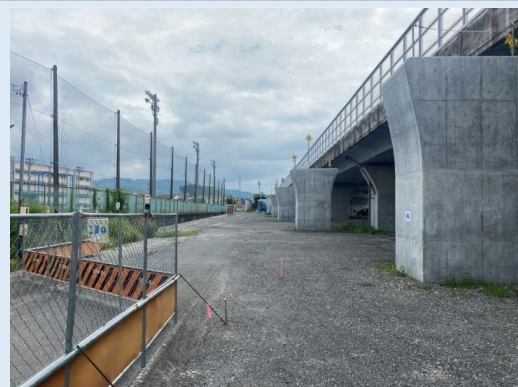
飯田OFFランプ橋 上部工施工前
