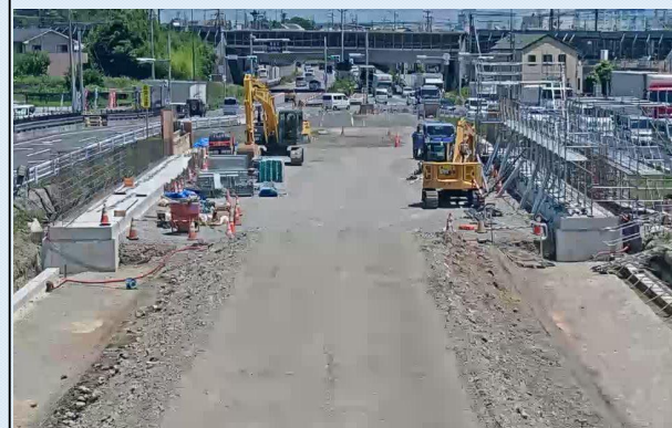
横砂地区 L型擁壁施工状況
