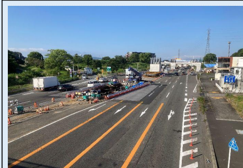
西久保交差点西側P23橋脚フーチング施工中
