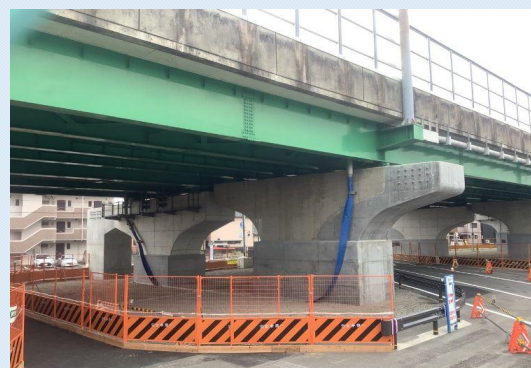
飯田高架橋P8橋脚補強・拡幅工事完成
