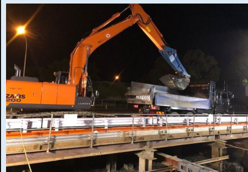
P25橋脚 2次掘削状況
