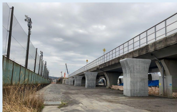
飯田OFFランプ橋 上部工施工前
