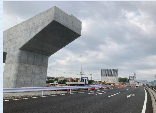
尾羽交差点西側P3・P4橋脚地組状況
