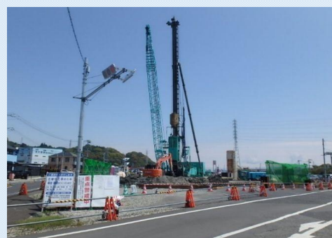
尾羽交差点東側：基礎杭施工状況
