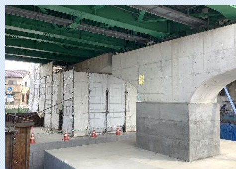
飯田高架橋P8橋脚：梁部施工状況
