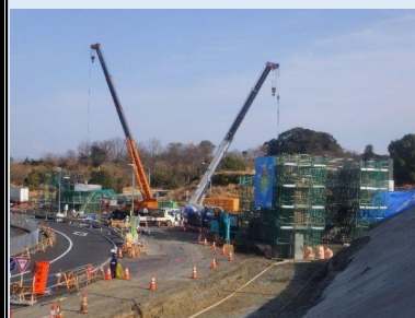
清水IC Gランプ橋 下部施工状況 (清水IC料金所側より望む)
