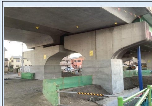
飯田高架橋 P7橋脚
