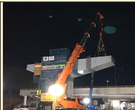
P27橋脚鋼製梁架設状況
