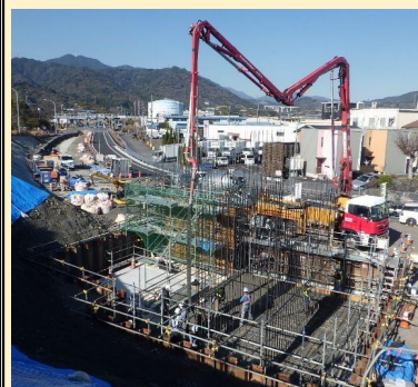
A1橋台 底版 コンクリート打設状況
