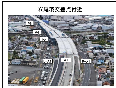
P2橋脚~P6橋脚 床版工 施工中
