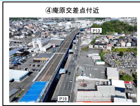
P13～P19橋脚 床版工 施工中
