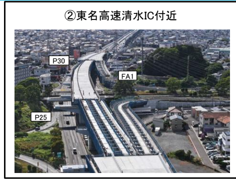
FA1～P30橋脚 床版工 施工中 P25～P30橋脚 床版工 施工中
