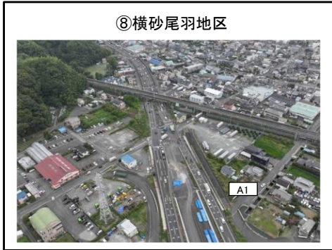
A1橋台、A2橋台間 擁壁工 施工中
