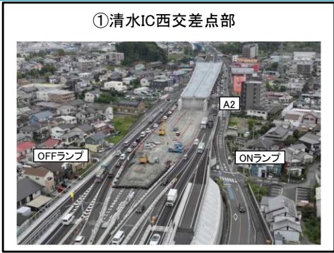
A2橋台西側擁壁部 地盤改良工 施工完了
