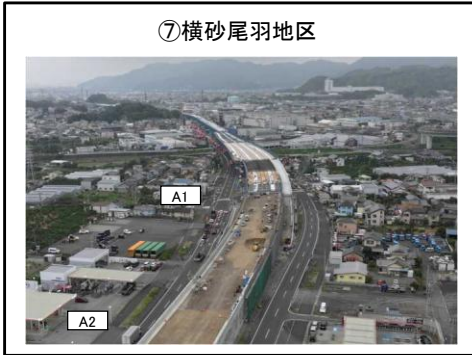
A1橋台、A2橋台間 擁壁工 施工中
