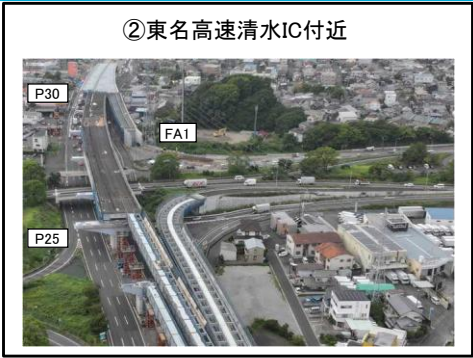
FA1〜P30橋脚 上部工 施工完了 P25〜P30橋脚 床版工 施工中
