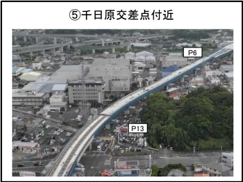
P6橋脚〜P13橋脚 床版工 施工中
