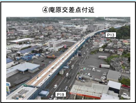
P13〜P19橋脚 床板工 施工中
